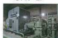
<⑥ タービン・発電機>
