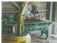
<② 燃料チップ化設備>
